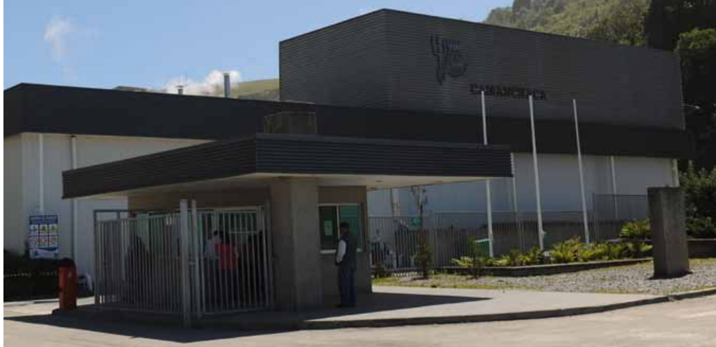
Planta de proceso de mejillones, Rauco, X Región
